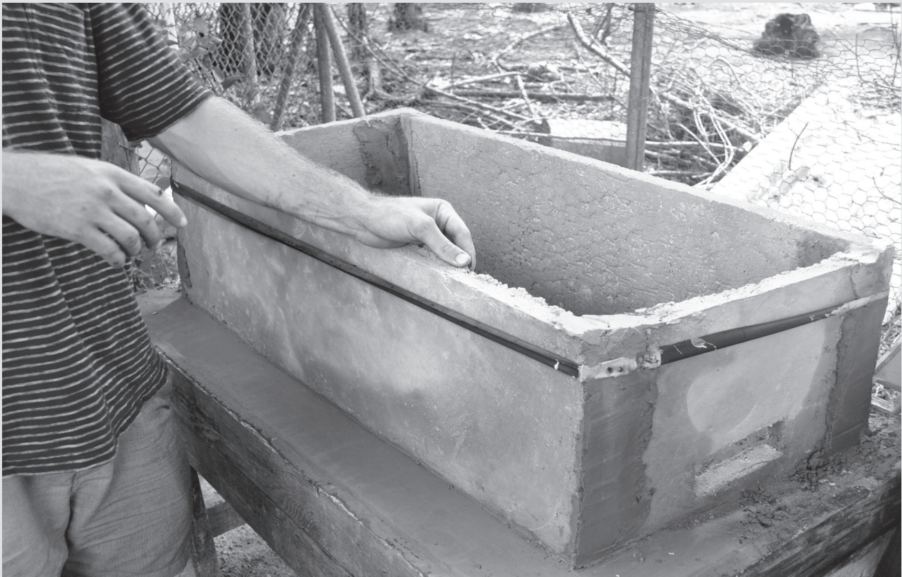
Las paredes montadas en la mesa.
